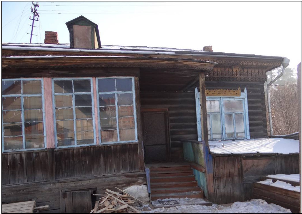
Фрагмент дворового фасада
