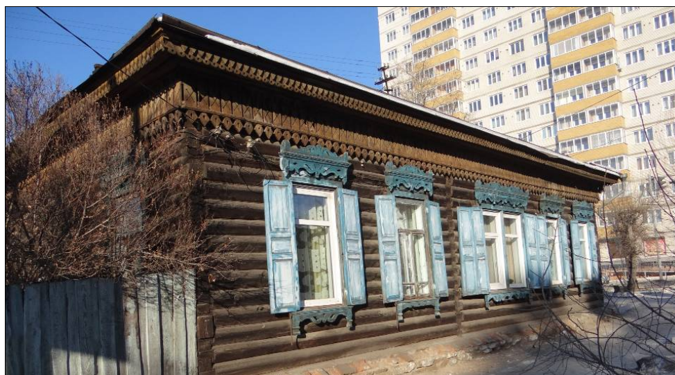
Главный фасад с ул. Ленинградская
